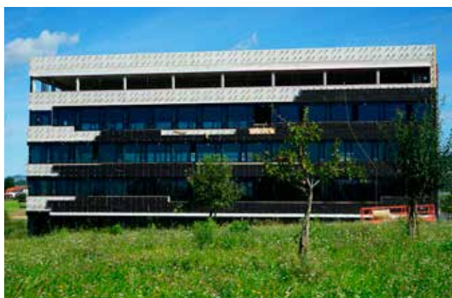
Gebäude COUNT IT Group & ventopay gmbh Foto: COUNT IT Group
